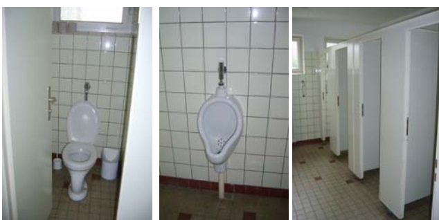
WC vor der Sanierung
