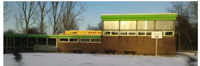
Turnhalle – Standort Technikzentralen
