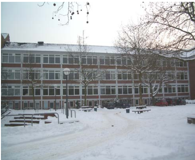
Haus A – Fassade Osttrakt nach Fenstersanierung
