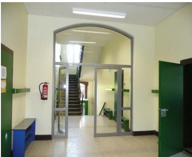
Flur nach der Sanierung
