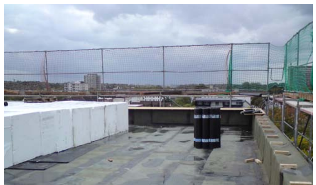
Dach Haus A-Bauphase vor Einbau der Dämmung
