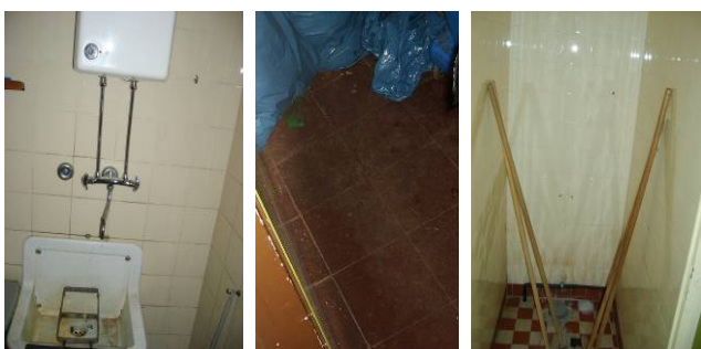
WC vor der Sanierung
