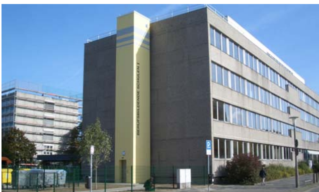
Aufzug Haus B
