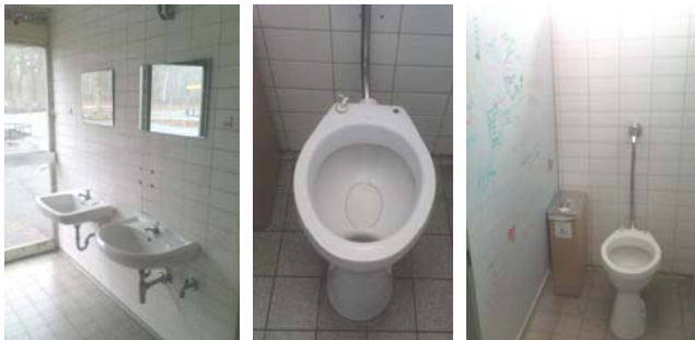
WC vor der Sanierung
