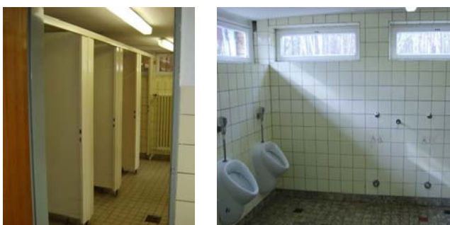
WC-Anlagen vor der Sanierung
