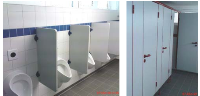
WC-Anlagen nach der Sanierung
