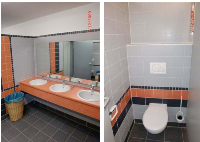
WC BBS III nach der Sanierung
