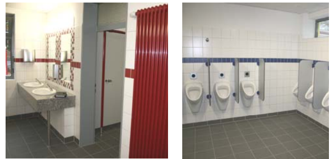
WC nach der Sanierung
