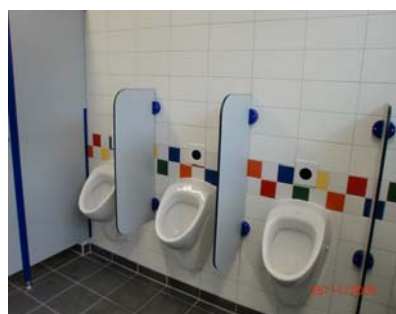
WC-Anlagen nach der Sanierung
