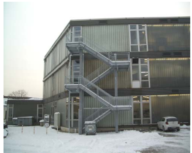
Haus E – Fluchttreppe, neu
