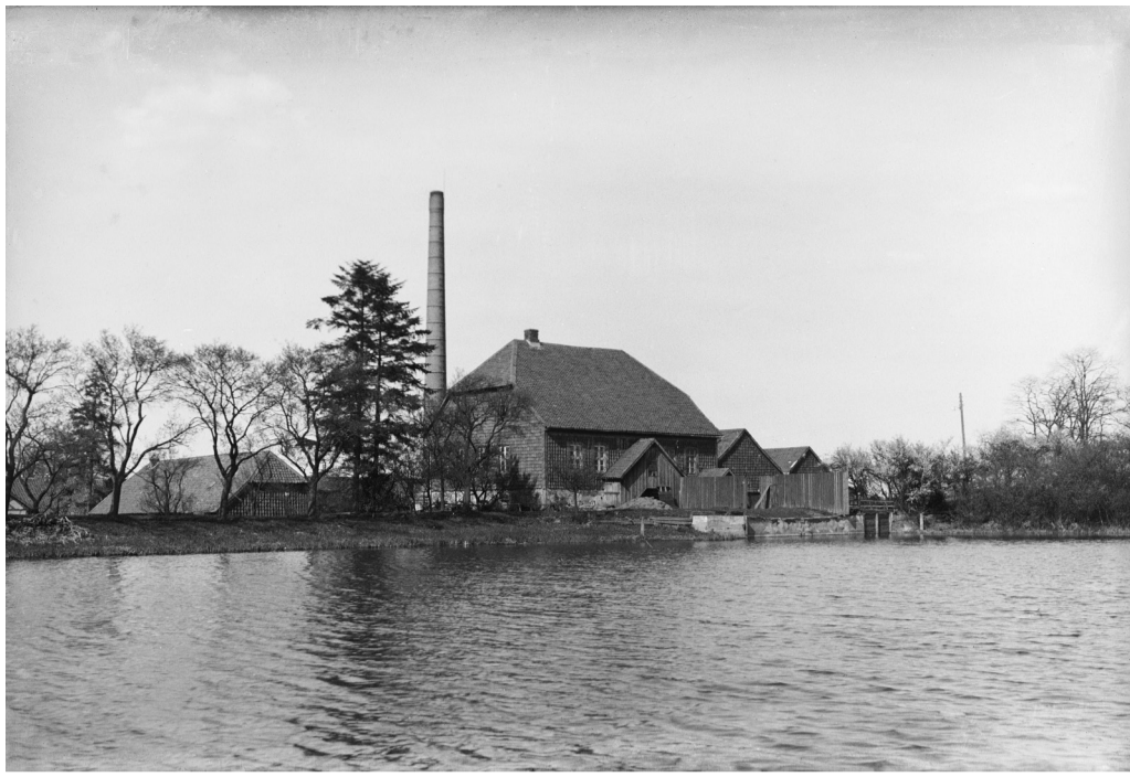
Die Schillermühle, ca. 1928. Foto: Walter Naucke
